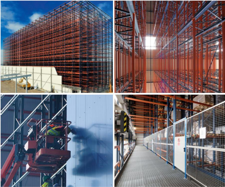
El almacén está construido con paneles sándwich de 10 cm de grosor y con núcleo aislante de poliuretano (PUR)
