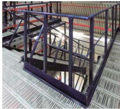
**Barandillas.** Las barandillas de protección están constituidas a partir de tubos redondos y rectangulares unidos entre sí. En la parte inferior se colocan zócalos de protección que evitan la caída de objetos desde la entreplanta.
