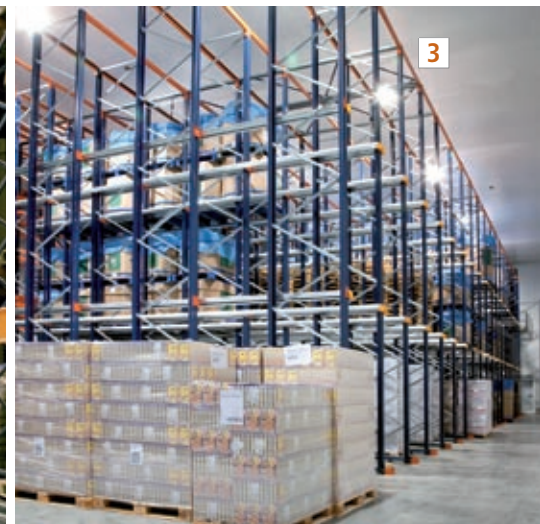
Los racks compactos permiten almacenar productos monoreferencia y que permanecerán largo tiempo almacenados.
