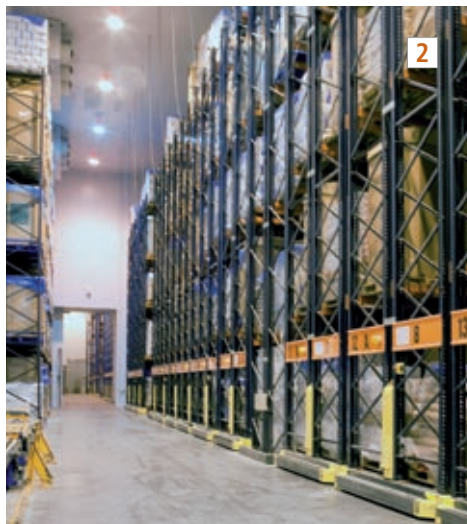
En los racks sobre bases móviles se almacenan los pedidos de media rotación o con tarimas de medidas variables.
