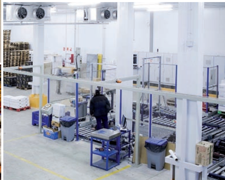
Operaciones de picking sobre la cabecera de un almacén automático.
