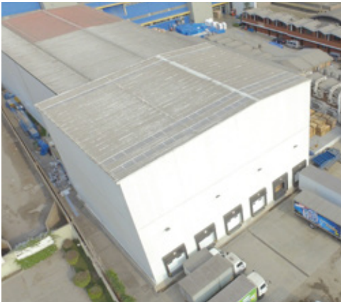
Imágenes de un almacén autoportante dedicado a almacenar productos a temperatura ambiente.
