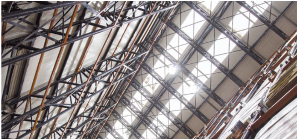
Imágenes de un almacén autoportante dedicado a almacenar productos a temperatura ambiente.
